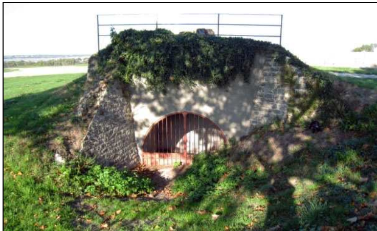
Batterie de 19 : entrée du puits d'accès aux magasins souterrains
