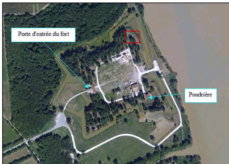
Emplacement de la batterie de 95 mm au fort Médoc (Rectangle rouge)
