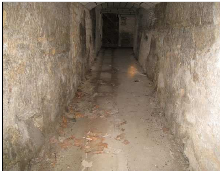
Fondations du chemin de fer de 40, reliant le magasin à poudre à la salle de chargement, dans le magasin souterrain de la batterie de 19
