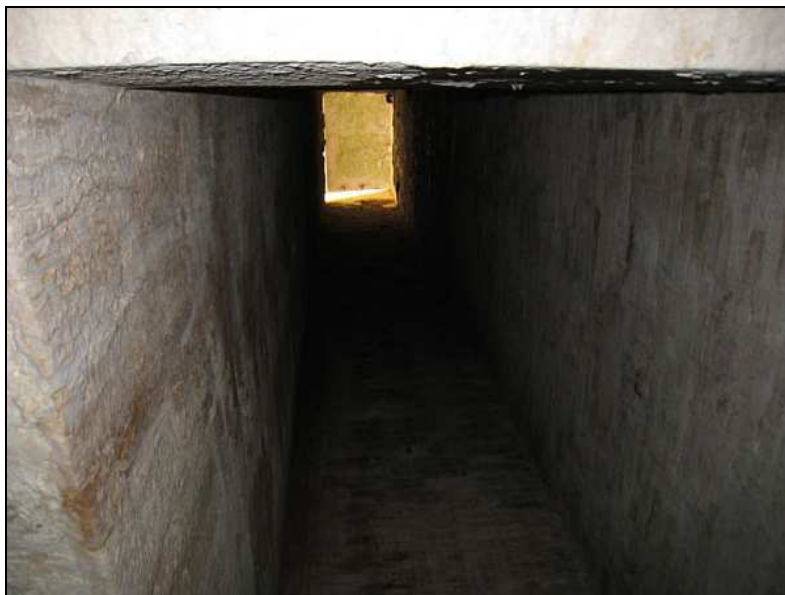
Puits d'accès aux magasins cavernes de la batterie de 19
