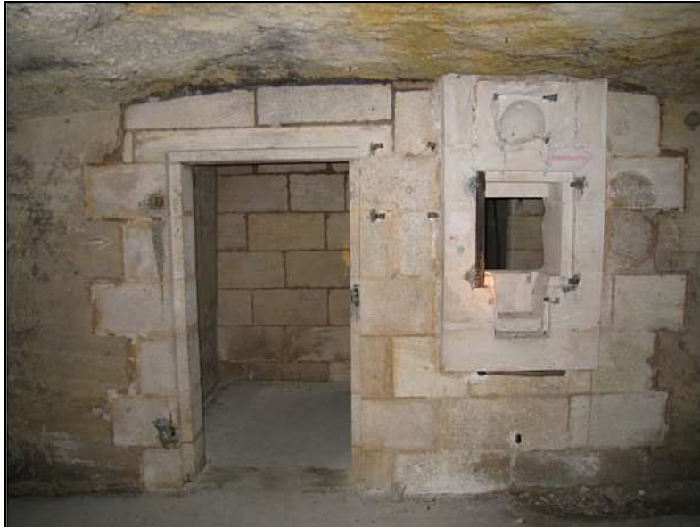
Entrée du magasin à poudre souterrain de la batterie de 95 mm
