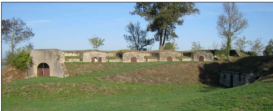
Vue générale de la batterie de 95
